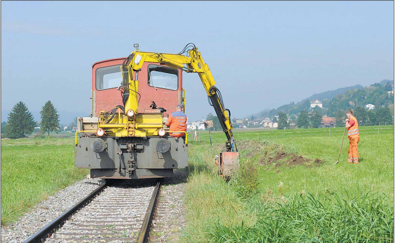
Am 26. September 2014 kam der Tm III mit der Baggerschaufel beim Freilegen eines Entwässerungsgrabens zwischen Geuensee und Büron zum Einsatz. (Fotos Matthias Emmenegger)
