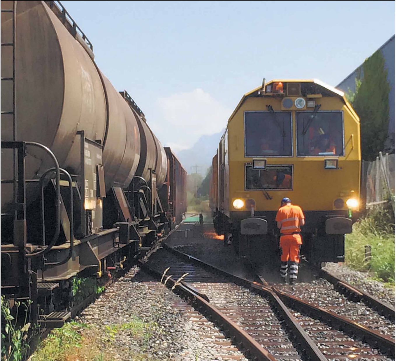
Der Scheuchzer-Schienenschleifzug kam auf die ST (Geuensee, 10. Juni 2014).
