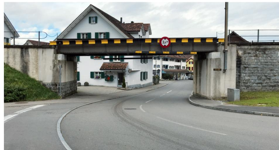
Genietete Stahlbrücke in Hinwil. Im Jahr 1899 erstellt und zwischen 1947 und 1949 verstärkt. Das Gleis befindet sich im Bereich der Brücke in einer engen Kurve im Radius 180 m und einem Gefälle von 25 Promille. Die Spannweite des Überbaus beträgt 12.71 m.
