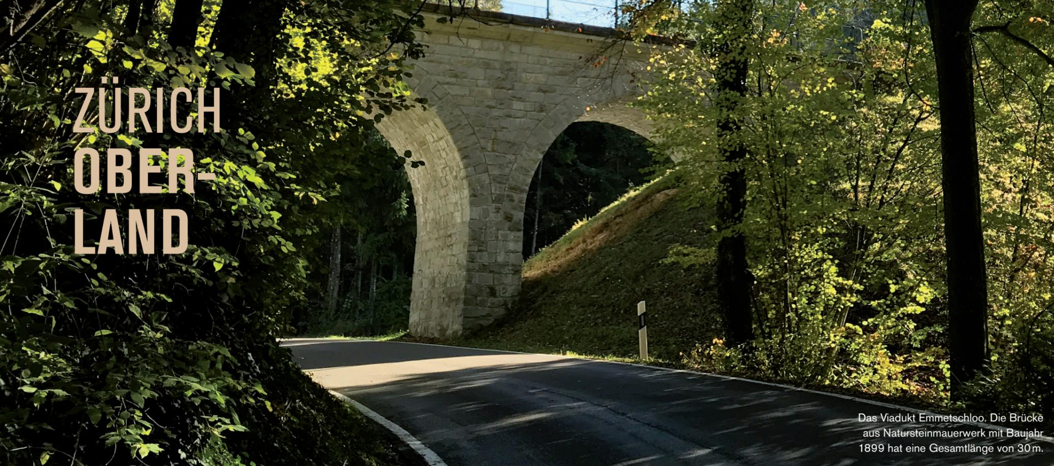
Das Viadukt Emmetschloo. Die Brücke aus Natursteinmauerwerk mit Baujahr 1899 hat eine Gesamtlänge von 30 m.
