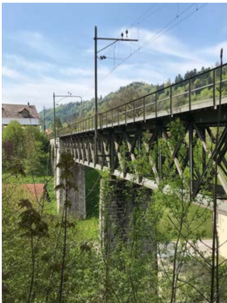
Der Neuthaler Viadukt
