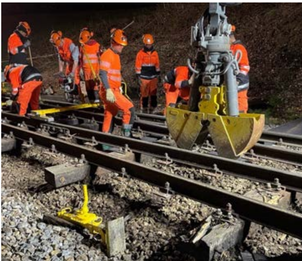
Schwellenersatz bei der Weiche 11 in Sursee
