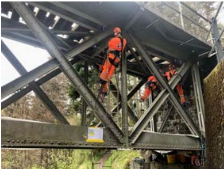
Inspektion am Neuthaler Viadukt.
