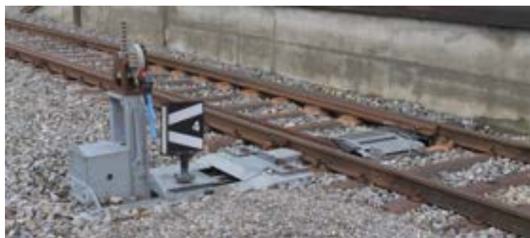
Alle Gewichtsstellböcke sind nun durch Weichenstellhebel ersetzt
