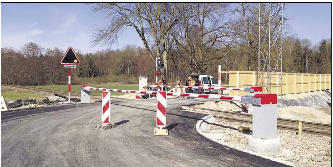
Der neue Bahnübergang beim Otto's-Zentrallager entsteht. Sursee Wassermatte, 22. März 2013.
