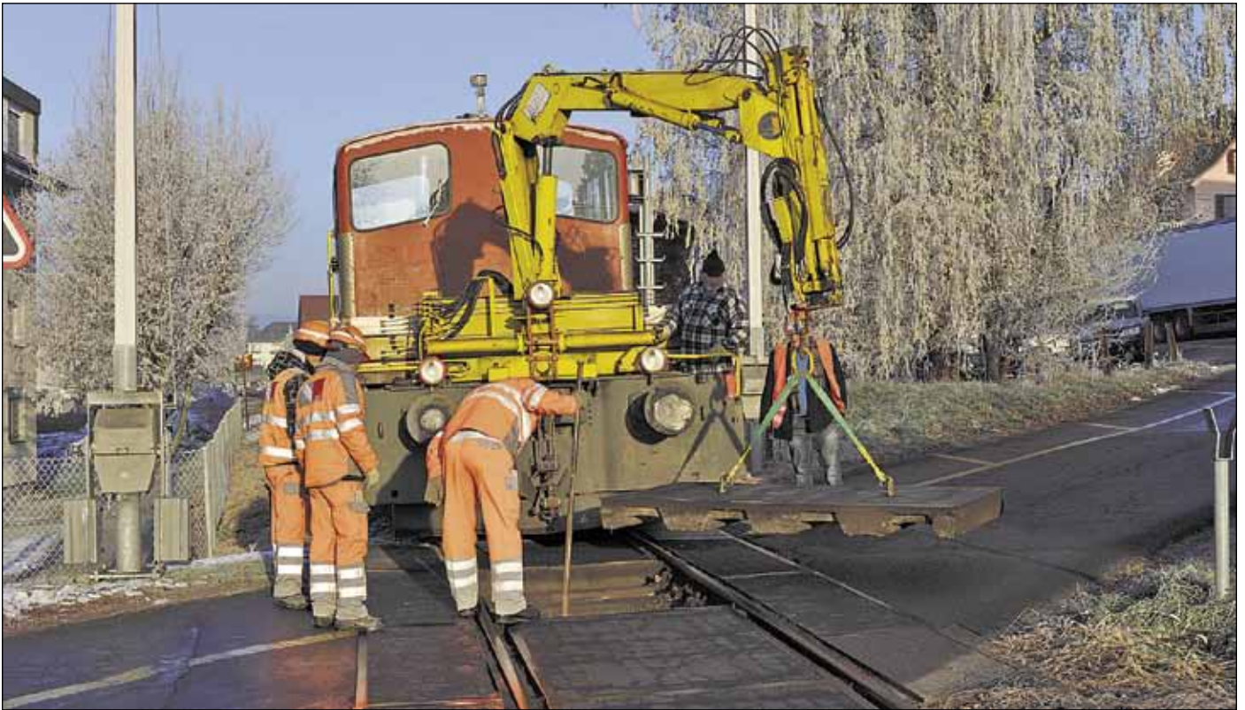
Der zweite Tm III: Neu gekauft und schon im harten Einsatz bei der Sanierung des Bahnübergangs in Triengen am 4. Dezember 2013. (Fotos Matthias Emmenegger)
