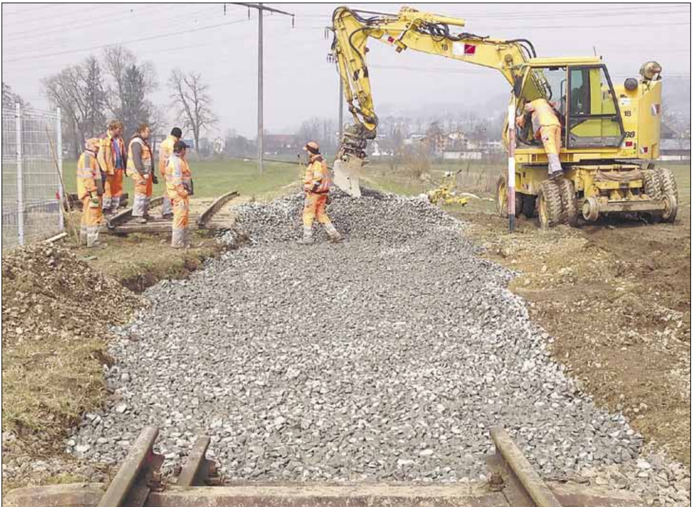
Rückbau des alten Zollbach-Durchlasses und Sanierung des angrenzenden Bahnübergangs. Sursee Wassermatte, 27. März 2013. (Fotos Matthias Emmenegger)
